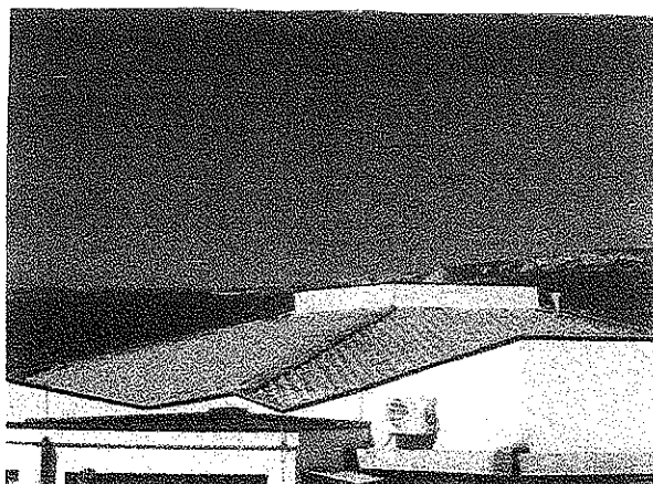
Krovište prije sanacije
