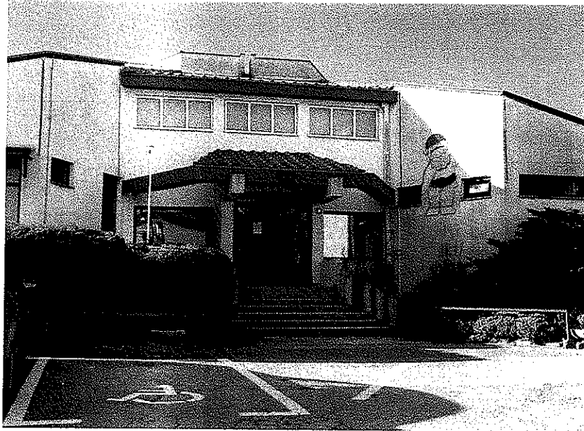
Dječji vrtić prije sanacije
